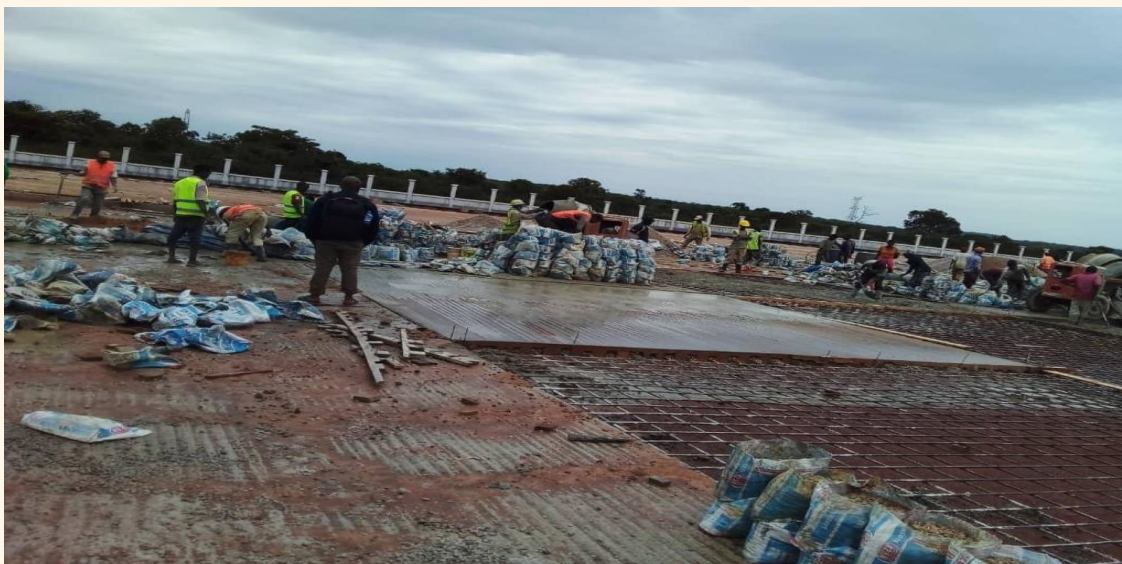
Picha ya ujenzi wa mradi wa kimkakati wa kituo cha malori Biharamulo DC
