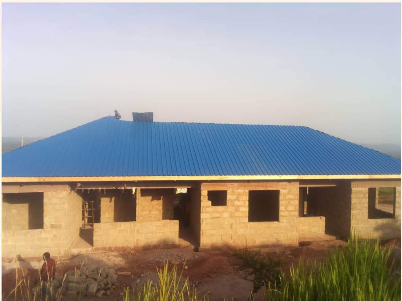
Picha ya ujenzi wa nyumba za watumishi wa Afya (3 in 1) Wilaya wa Karagwe
